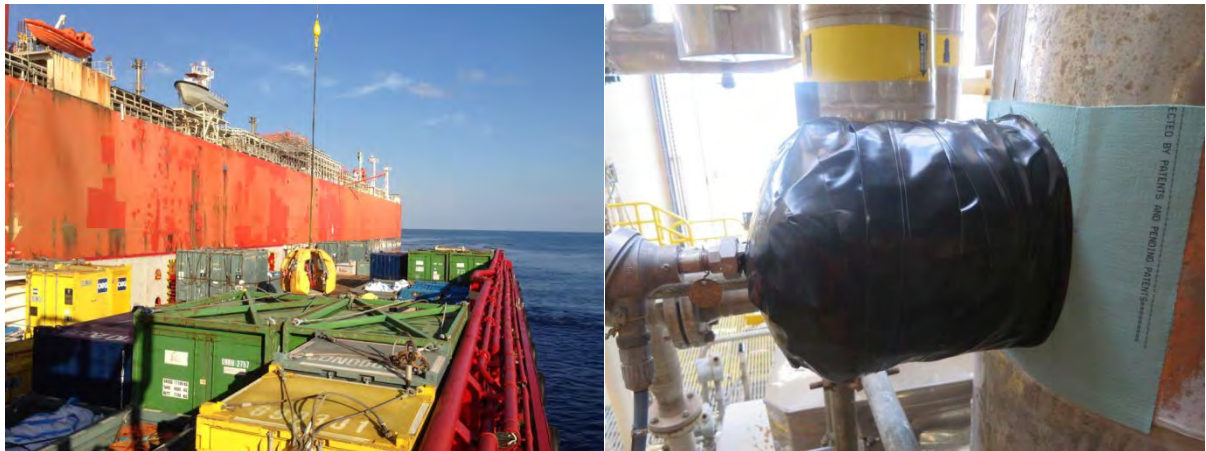
FIGURA 25: EKIPA MANUTENSAUN TRANSFERE BA BU FSO UZA OPERASAUN FROG UZA PREZERVA STOPAQ
