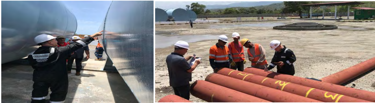
FIGURA 37: INSPEAUN BA RESERVATORIU NO TUBAGEM KOMPAÑIA LAI-ARA NIKMAT MUJUR, KAITEHU LIQUIÇA
