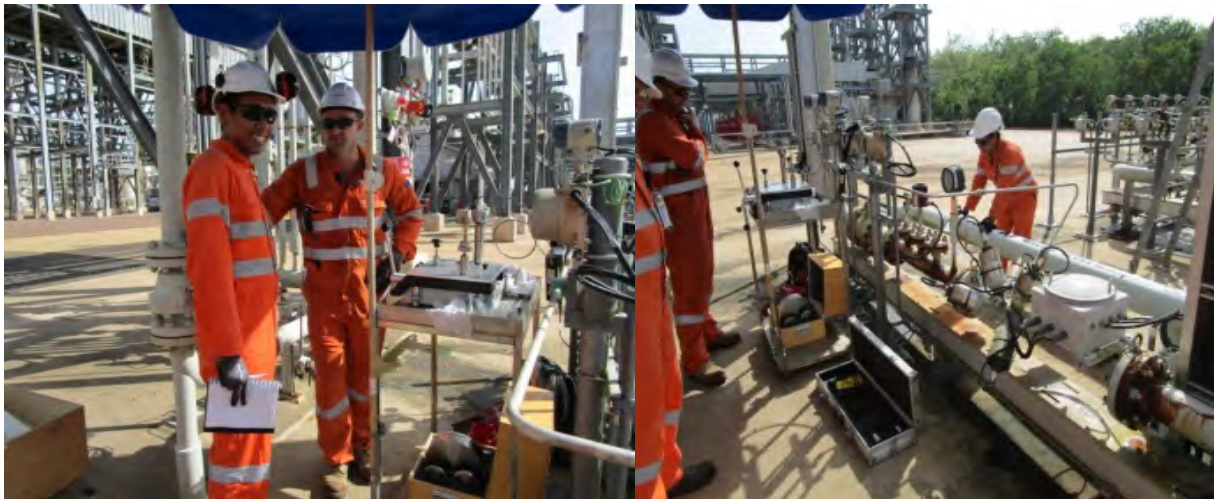
FIGURA 22: EKIPA SASUKAT HALA'O INSPAUN IHA FASILIDADE DLNG
