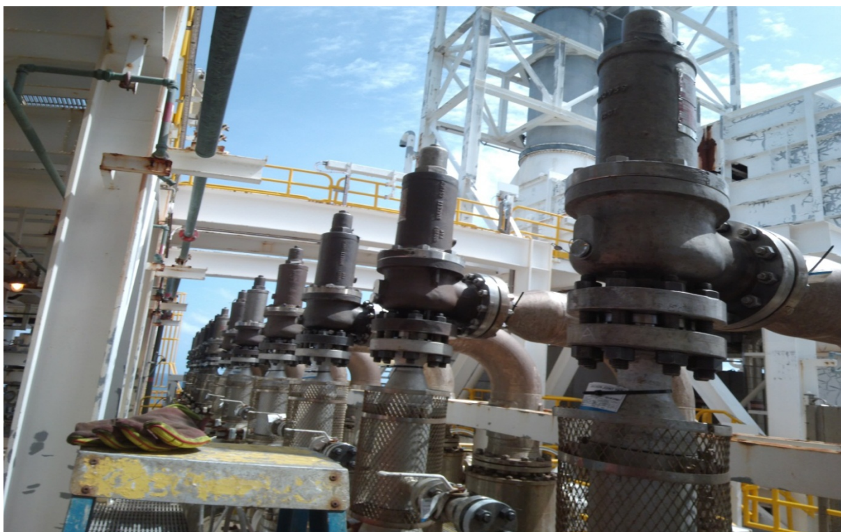
FIGURA 24: INSPAUN BA PSV SIRA NE'EBÉ HALA'O DEPOIS KAMPAÑA MAIU 2020 REDUSAUN VOLUME ESTENDIDA (EXTENDED RATE REDUCTION) LOKALIZA IHA PLATAFORMA BAYU-UNDAN
