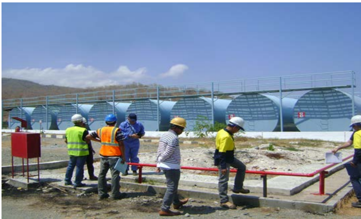
FIGURA 28: INSPEASAUN BA FASILIDADE ARMAZENAMENTU LAI-ARA NIKMAT MUJUR-KAITEHU, LIQUICA
