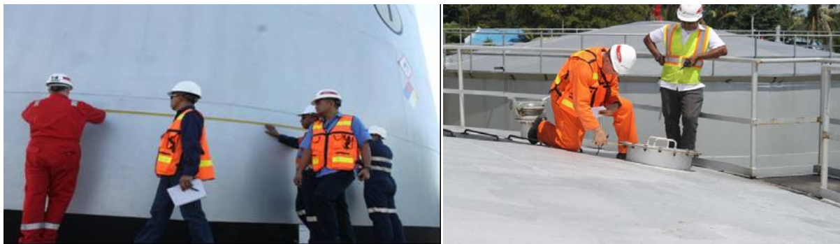
FIGURA 23: INSPESAUN EXTERNA BA ARMAZENAMENTU NIA LOLON & NIA KOBERTURA IHA INFRAESTRUTURA KOMPAÑIA PITSA
